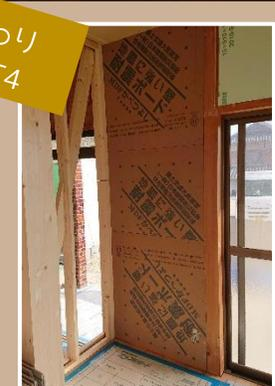
これからも安心して長く住み続けられるお家を目指して耐震診断を実施。補強が必要な箇所に耐震ボードや金物を取り付けて、評点 1.0 の基準をクリアしたお家に仕上げました！
